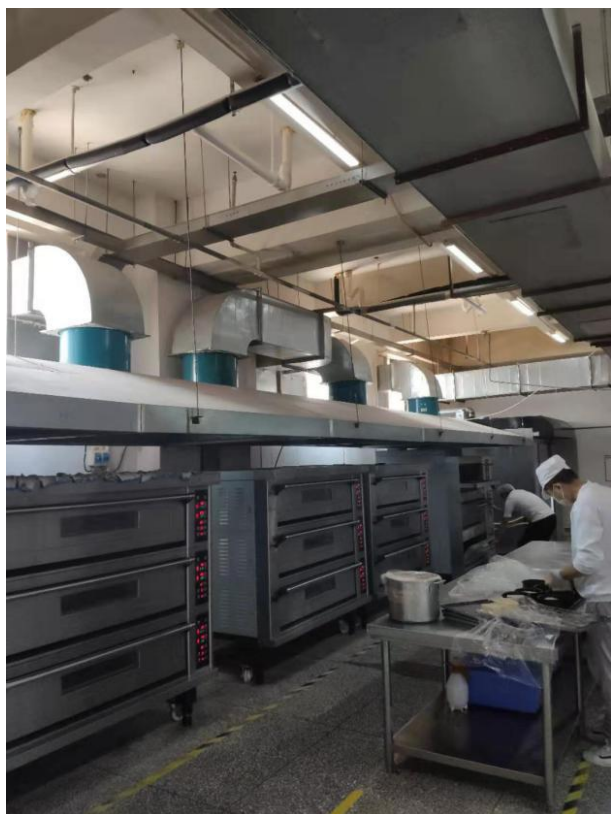
生产车间内部
