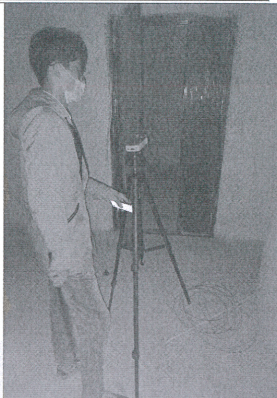
N8: 消防水泵房
