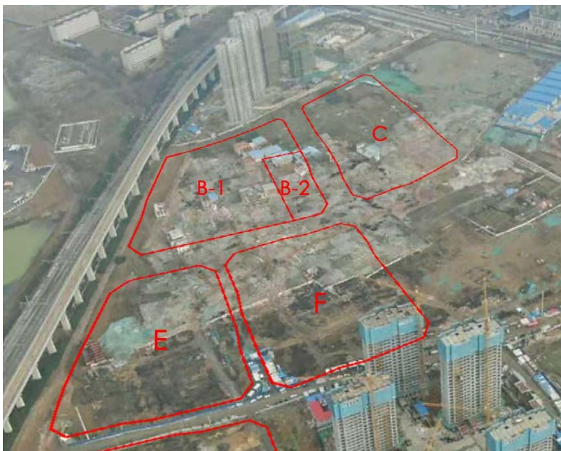
开工前项目现状图
