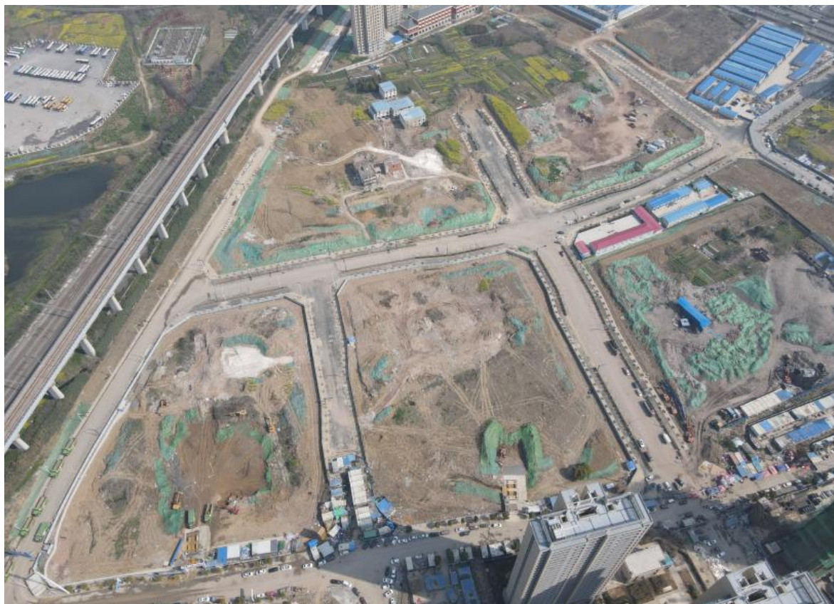
图 2.4 项目开工初期现场照片
