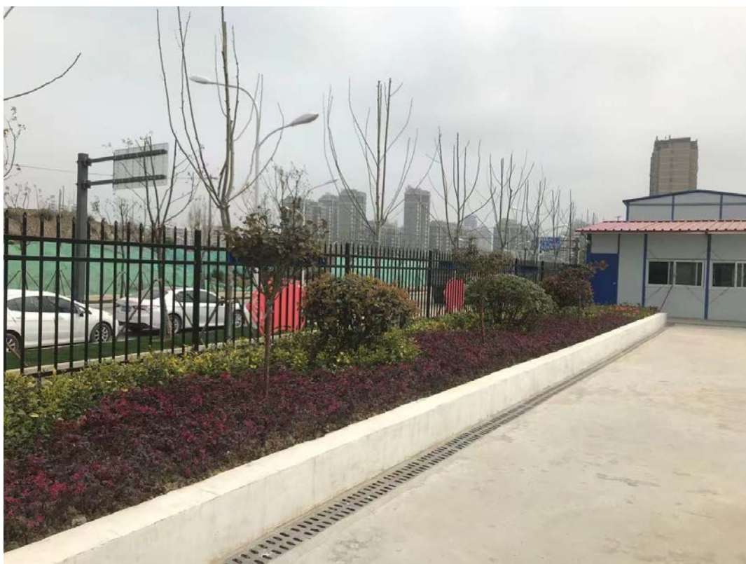
施工生产生活区临时排水沟
