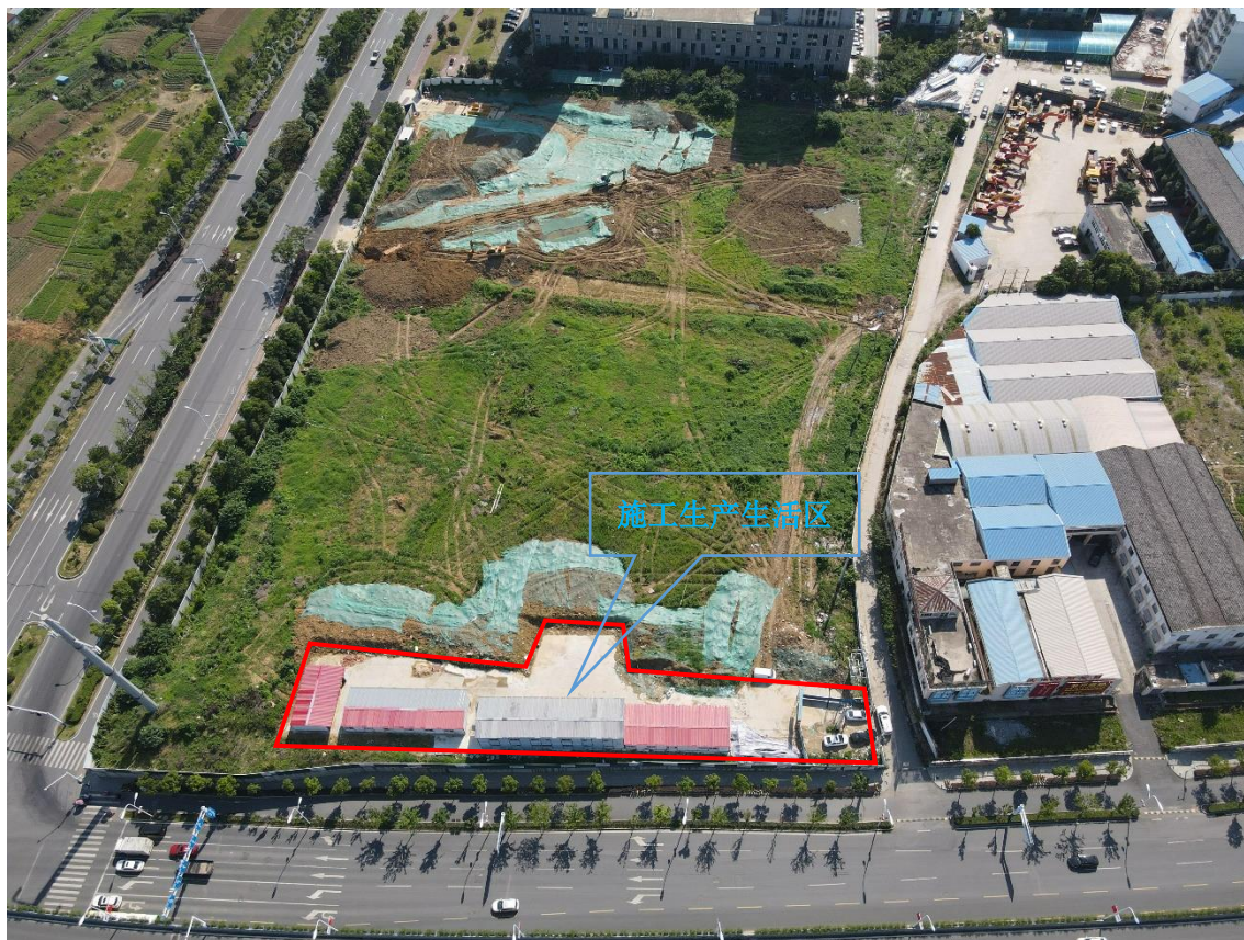
图 2.9 施工生产生活区
