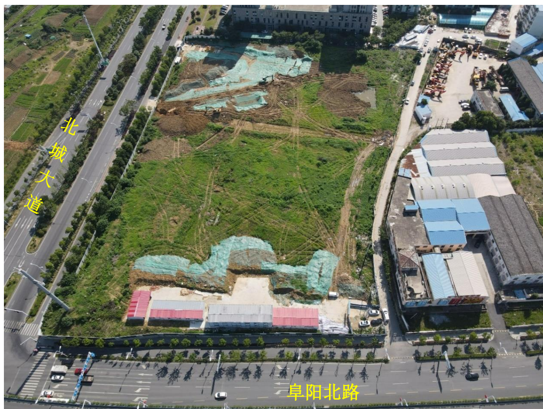
图 2.13 项目开工初期现场图
